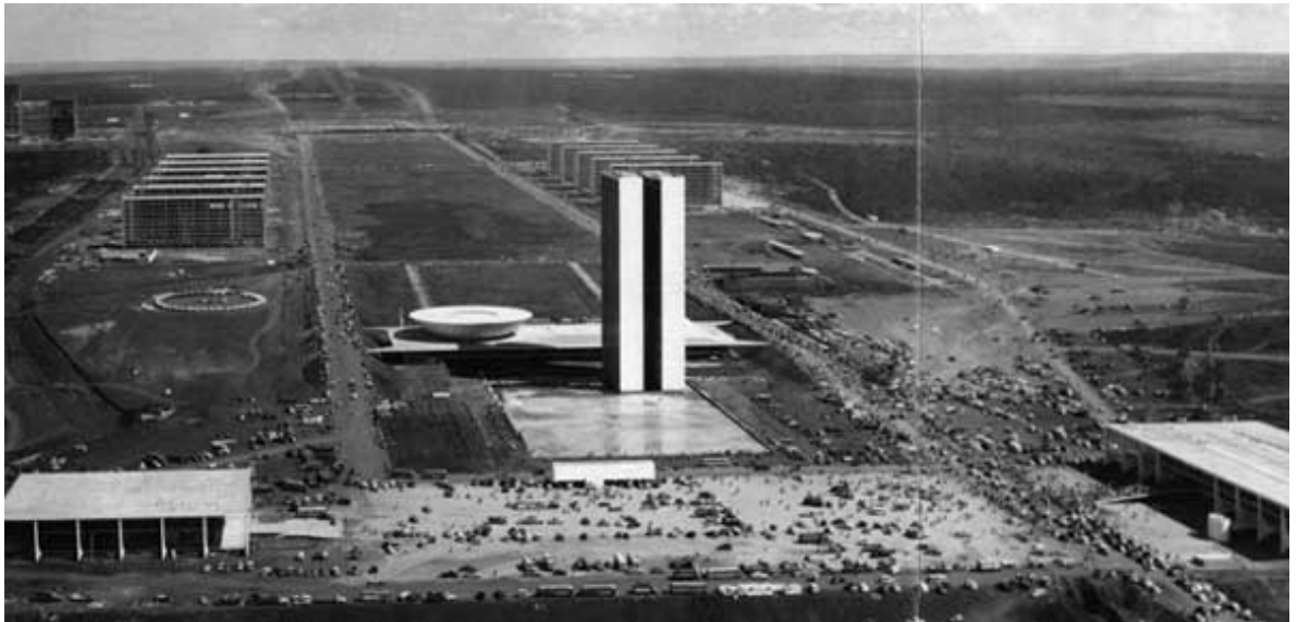
Construção de Brasília
